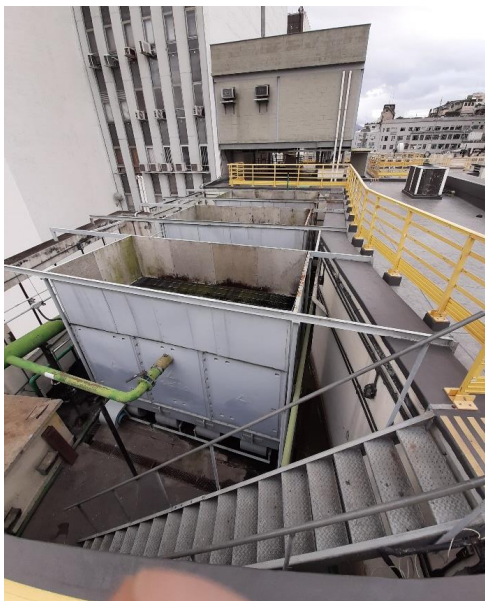
Torres vistas de cima e visualização do lado de acionamento dos ventiladores da torre 1
